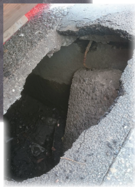
穴が開いた歩道には現在、コンクリート製の蓋がおかれています。
